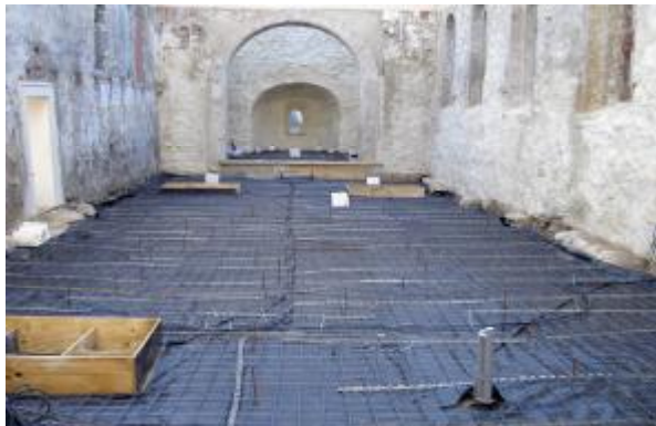
Bild 2: Einbau Bewehrung mit Trennlage
