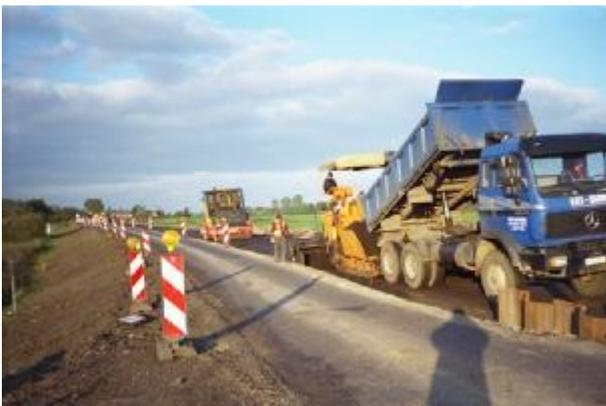
Bild 11: Unterbauverbesserung
